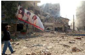
Zerstörte Gebäude nach israelischen Angriffen im Süden Beiruts. Foto Keystone/EPA
